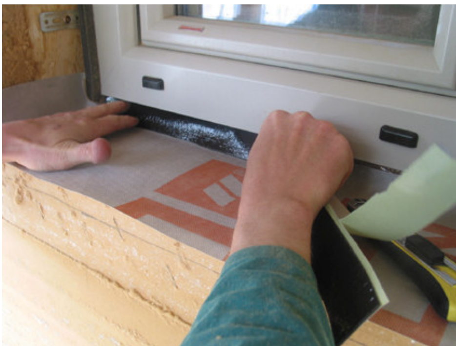
Slika 6: Veliko pozornosti je bilo namenjene izolaciji in tesnjenju detajlov pri stavbnem pohištvu: preko komprimiranega traku, ki se prilega neravninam, je nameščen še hidroizolacijski trak.
