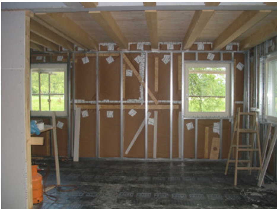
Slika 5: Za parno oviro je zunanja stena že napolnjena s celuloznimi kosmiči, stiki med različnimi materiali ter odprtine v parni oviri pa zatesnjeni z Air stop trakom.
