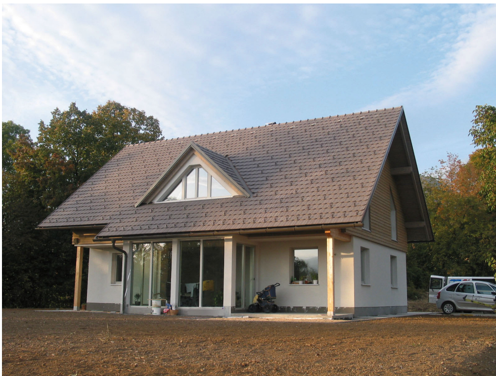
Slika 2: Pogled z juga: hiša je na ravnini brez visokih ovir na jugu, izbočeni del osrednjega prostora v hiši je obdan v stekla.
