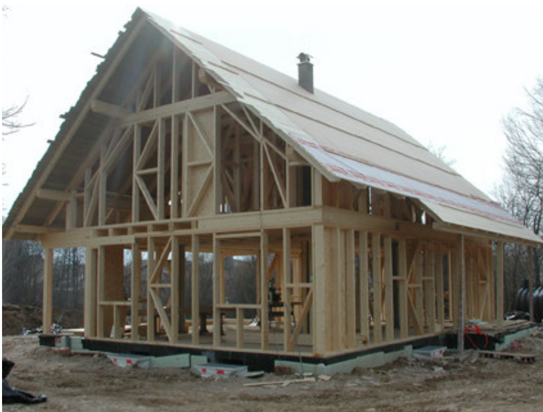
Slika 4: Pogled iz severovzhoda: lesena skeletna gradnja čaka na fasadne plošče, sekundarna Agepan kritina pa na strešnike.
