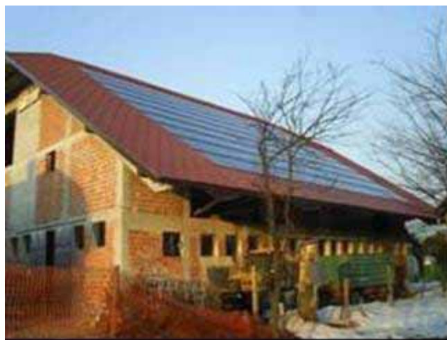
Slika 19: SE Jarše pri Domžalah 35,6 kW, zgrajena leta 2006
