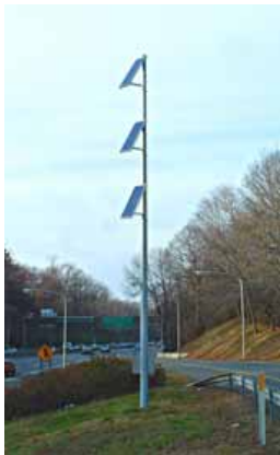
Slika 4: Uporaba fotonapetostnih modulov za napajanje naprav za merjenje in obdelavo statističnih podatkov v prometu
