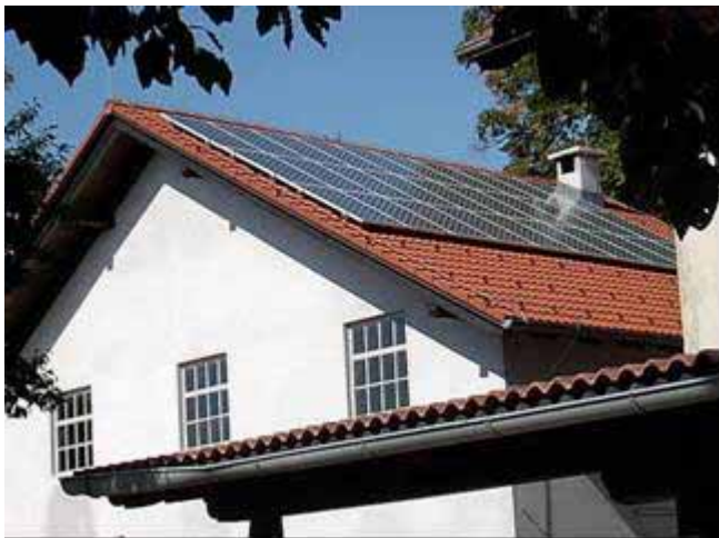
Slika 18: Sončna elektrarna NANOS 4,5 kW, zgrajena leta 2003 kot otočna, leta 2006 priključena na električno omrežje
