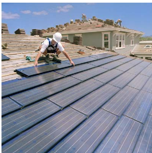
Slika 5: Integracija sončnih celic na stavbo ter primer sončne elektrarne
